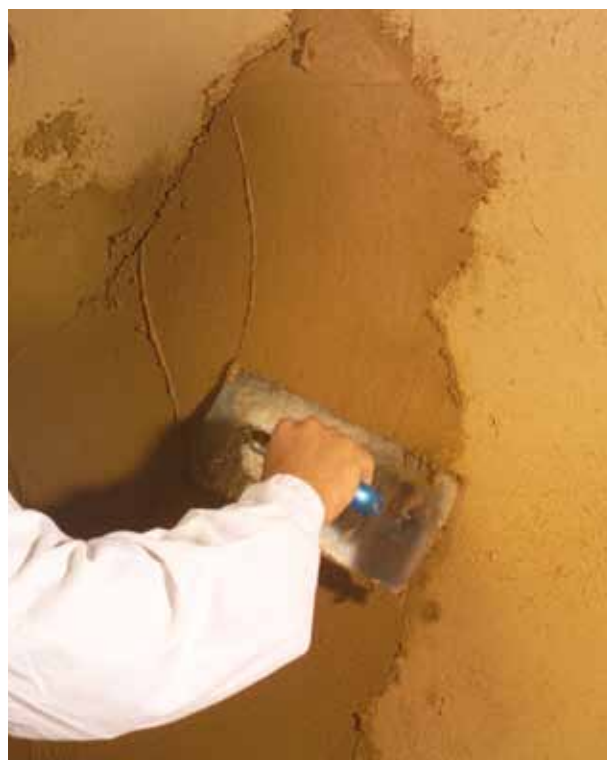
afbeelding 6.1.4: Na droging: opbrengen van afwerkleemfijn met een RVS gladspaan. Laagdikte 2-3 mm
