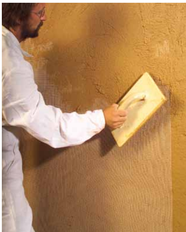
afbeelding 6.1.3: zorgvuldig inwerken van de wapening met een sponsbord
