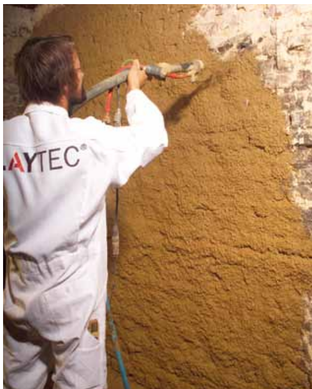
afbeelding 6.1.1: opspuiten van basisleem met pleistermachine op een bakstenen muur
