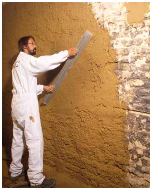
afbeelding 6.1.2: grof afreien van de pleister met een aluminium reilat.
