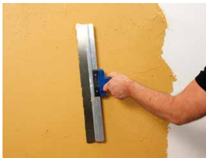
Aftrekken met de oppervlaktespatel
