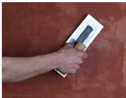
Uitvoering gevulde finish-coatings
