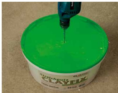
Bij gesloten deksel mengen
