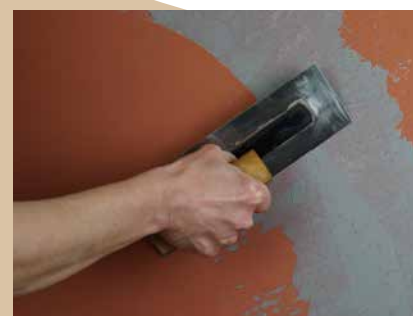
Applicatie van de gemarmerde deklaag
