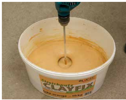
Na 30 minuten weektijd goed doorroeren
