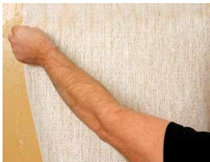
Verlijmen van het glasweefselbehang
