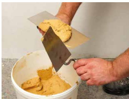
Verwijderen van de mortel
