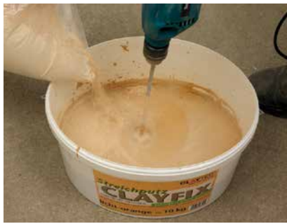
Doorroeren van de emmerinhoud in water
