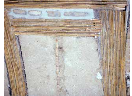
Rietweefsel St70 op houten balken van een vakwerkmuur
