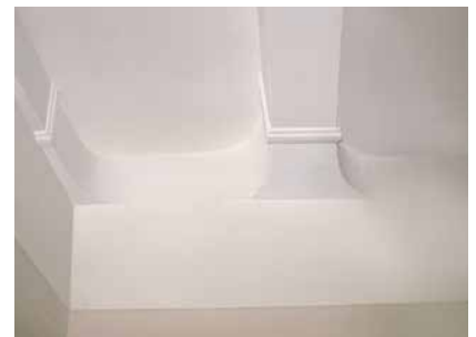
Plafond met bepleisterde balken, afgeronde voegen en stucprofielen
