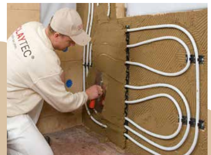
De basispleister wordt over de buisopzetstukken getrokken.
